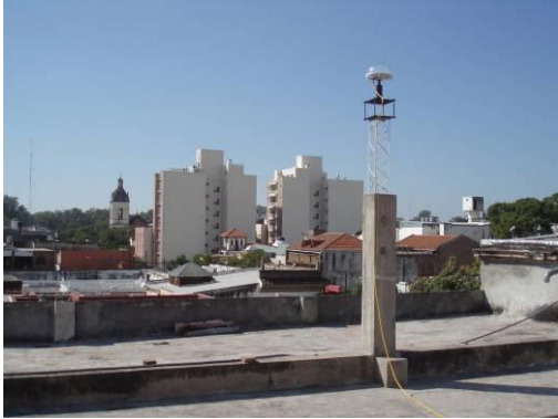
Estructura metálica empotrada en la terraza de la Dirección de Catastro de Santiago del Estero.
