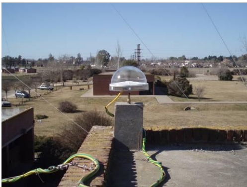
Pilar construido sobre tanque de agua de la Universidad Nacional del Centro, Azul, Provincia de Buenos Aires.
