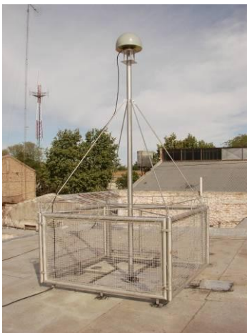
Mástil construido sobre la azotea de la municipalidad de San Rafael, Mendoza.
